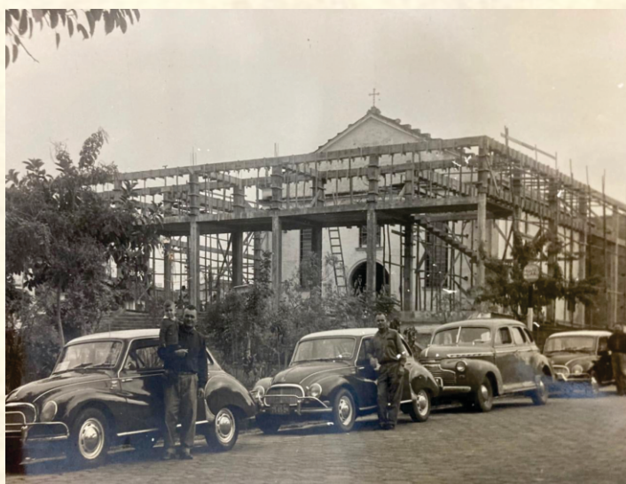
#PRACEGOVER Obras de construção da nova Igreja Matriz de São Benedito. Limeira, SP. Entre 1961 e 1964. Acervo Museu Eclesiástico da Diocese de Limeira, Limeira, SP.
